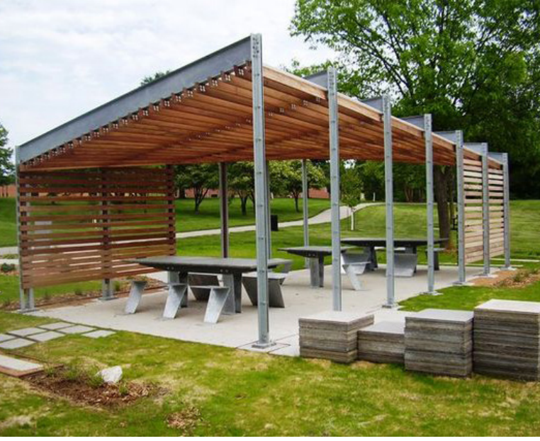
Shade Structure/Picnic Pavilion / Estructura de sombra/Pabellón Picnic
